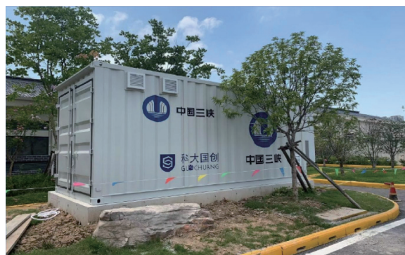
公司承建中国三峡集团污水处理厂储能微网系统项目
